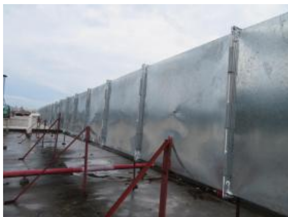
E栋1#通风管缝隙用玻璃胶增加密封性
