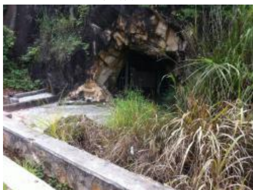
矿坑涌水排水涵洞
