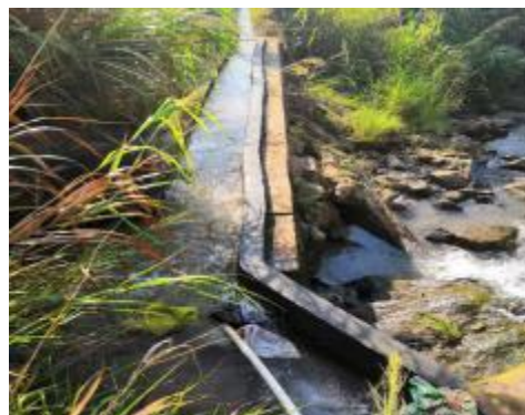
矿坑涌水排水渠
