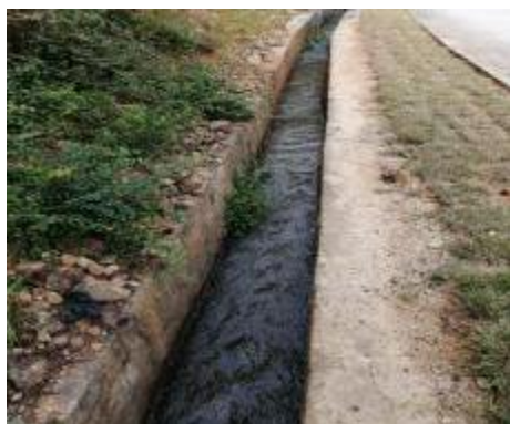
矿坑涌水排水涵洞
