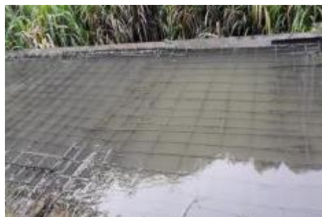
场外矿坑涌水沉淀仓
